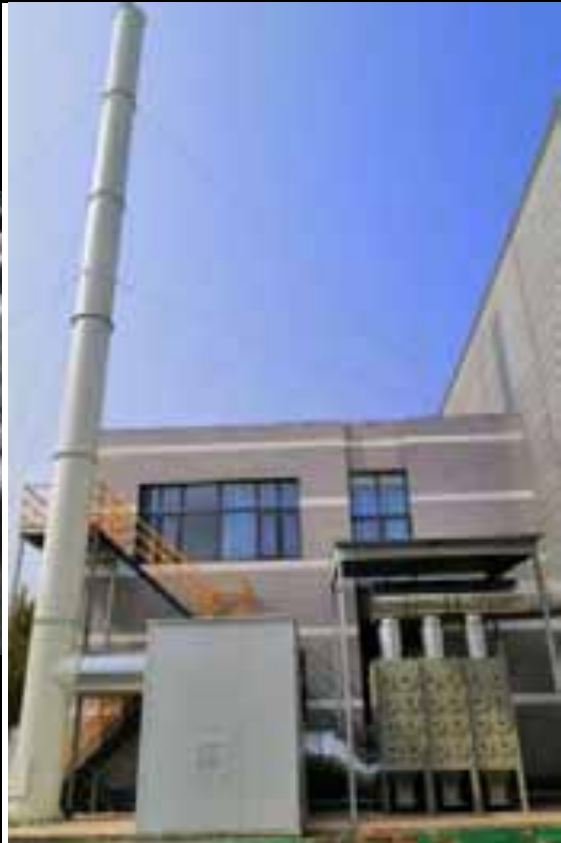
滤筒除尘器+排气筒 P17 规范化
