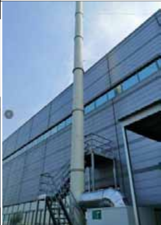
滤筒除尘器+排气筒 P19 规范化
