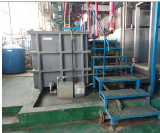
电镀车间地面围堰
