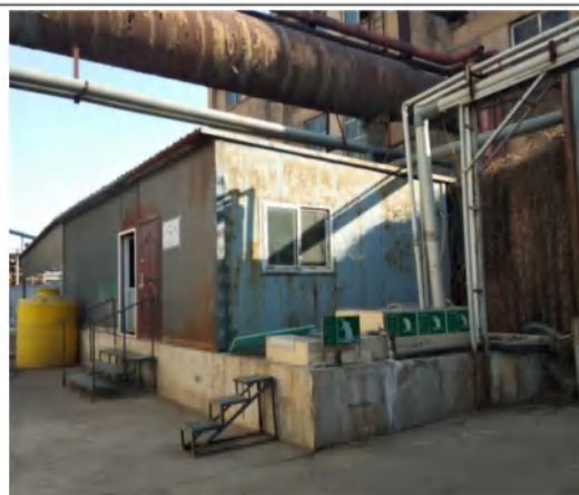
废水总排口及标识牌
