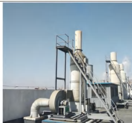
电镀废气排气筒采样平台、采样口、标识牌
