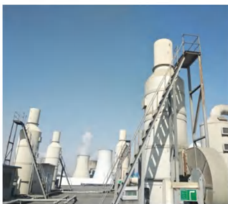
电镀废气排气筒采样平台、采样口、标识牌
