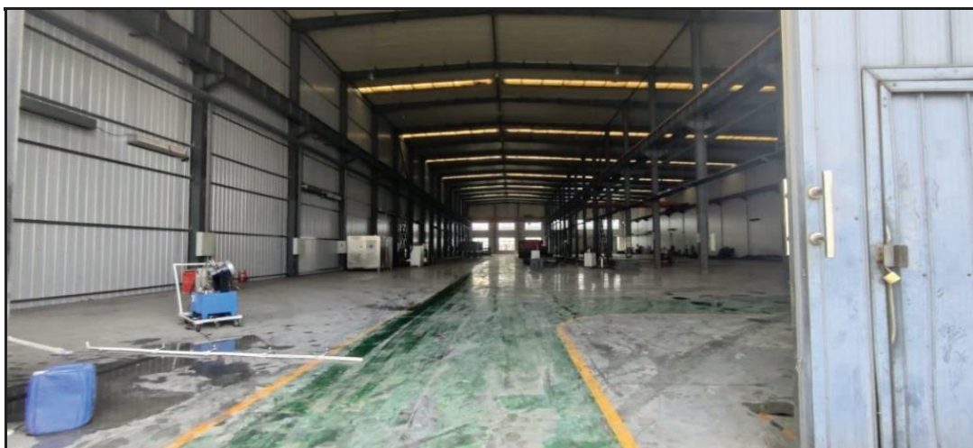
图 2-1 本项目生产厂房现状图
